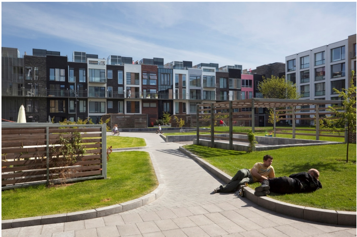
Bilde 3: Viser eksempel på oppdeling av fasader i Sluseholmen i København.
