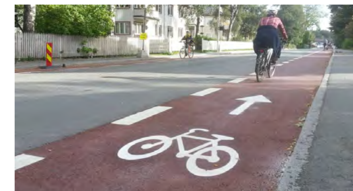
FIGUR 21: SYKKELFELT MARKERT MED RØD ASFALT KAN BENYTTES I BY- OG TETTSTEDSOMRÅDER MED MODERAT TRAFIKK OG FARTSGRENSE. FOTO: MILJØPAKKEN.NO
