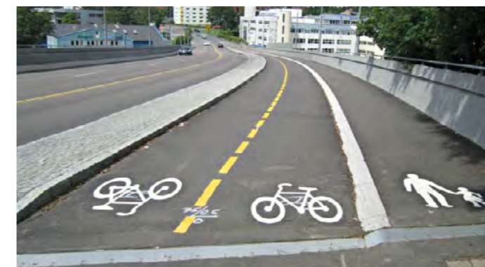
FIGUR 24: SYKKELVEI MED FORTAU OPPARBEIDET MED IKKE-AVVISENDE KANTSTEIN OG SYMBOLMERKING I ASFALTEN. SYKKELVEIEN ER HER ADSKILT FRA KJØREBANEN MED KANTSTEIN OG BUFFERSONE TIL KJØREVEI. FOTO: OSLO KOMMUNE, BYMILJØETATEN.
