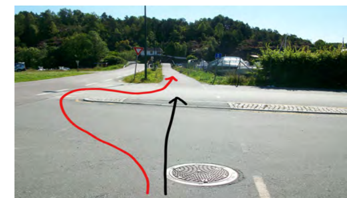
FIGUR 2: MANGE TRAFIKKØYER ER OPPARBEIDET MED FORHØYET KANTSTEIN I MIDTEN. DETTE GJØR DET VANSKELIG FOR BÅDE SYKLISTER OG ANDRE Å PASSERE. SYKLISTER VELGER OFTE Å SYKLE UTENOM FOR Å UNNGÅ UBEHAGET VED Å SYKLE OVER KANTSTEINENE. DETTE GIR ET URYDDIG TRAFIKKBILDE, OG ER IKKE UNIVERSELL UTFORMING.
