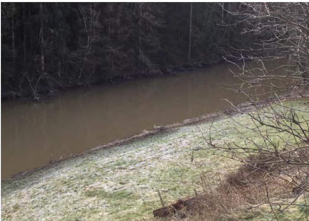
Figur 5. Bilde av elvebredden ved Elveveien 87, tatt i retning sør. Observert grumsete vann og aktiv erosjon langs elvebredden.
