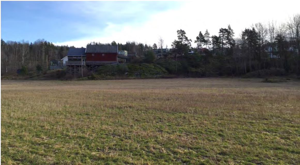
Figur 10. Bilde tatt ved elvebredden i retning sør. Nordre Labu gård (i bilde) er fundamentert på berg i dagen.
