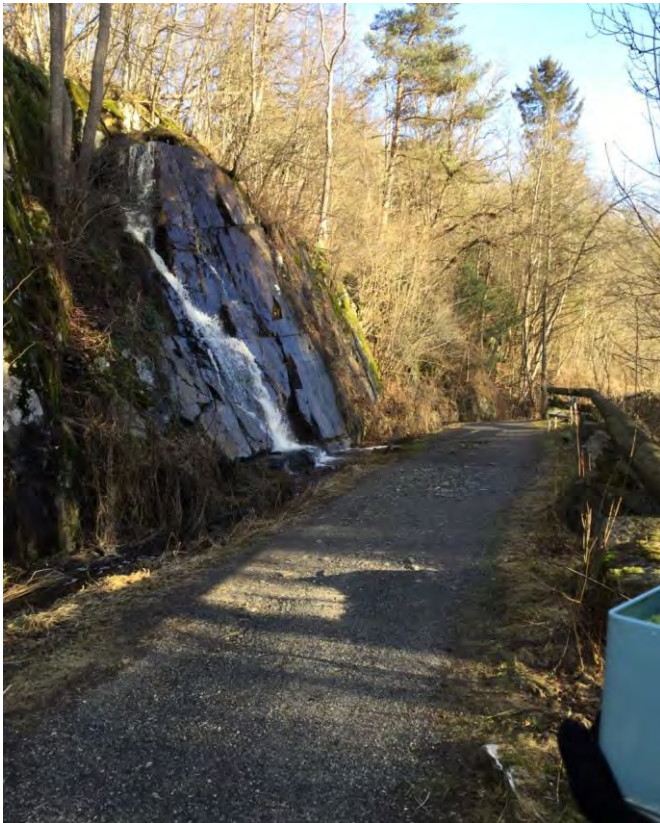
Figur 2. Tatt i retning øst langs bilvei. Vannet renner langs bergsiden og føres under veien i rør. Vannet renner videre ned i en ravine.
