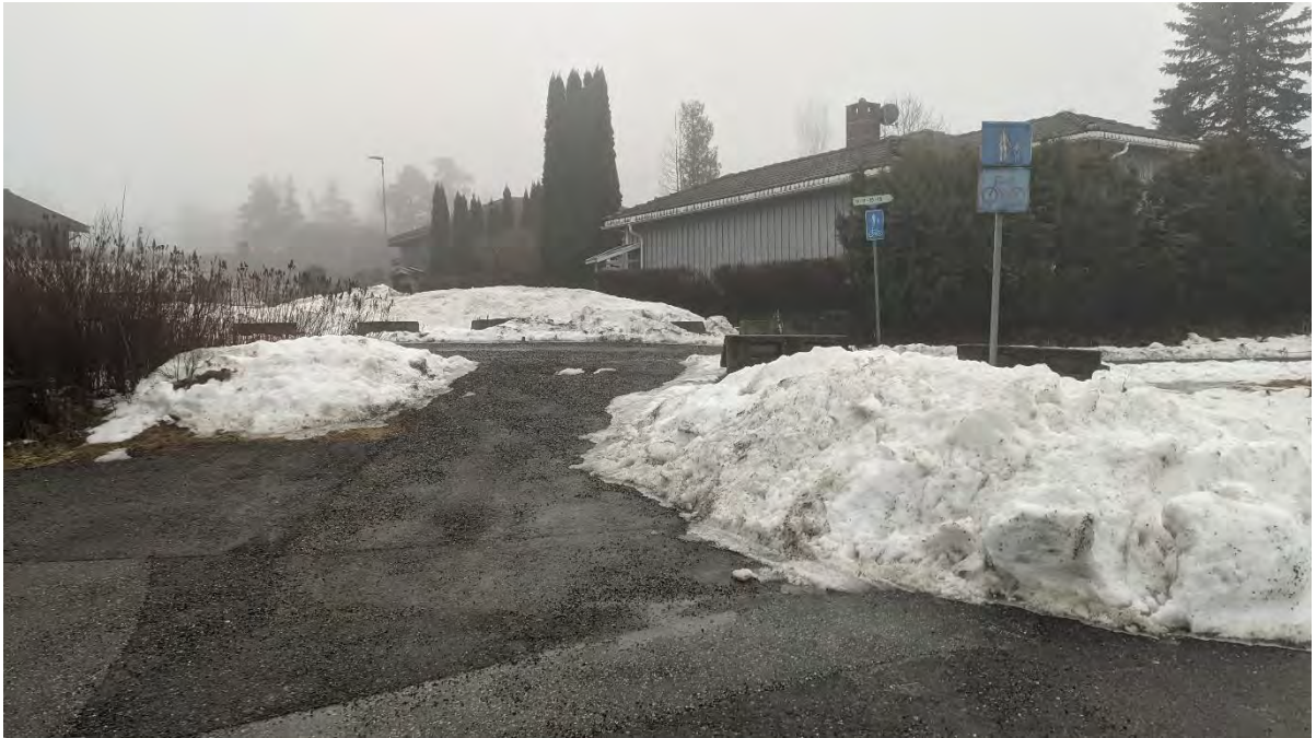
Figur 13 Bildet viser tilrettelegging mellom Tyriveien og gang- og sykkelvei, samt manglende tilrettelegging mellom gang- og sykkelvei og Lindeveien. bildet er tatt fra Tyriveien mot Lindeveien (Foto: Rambøll)
