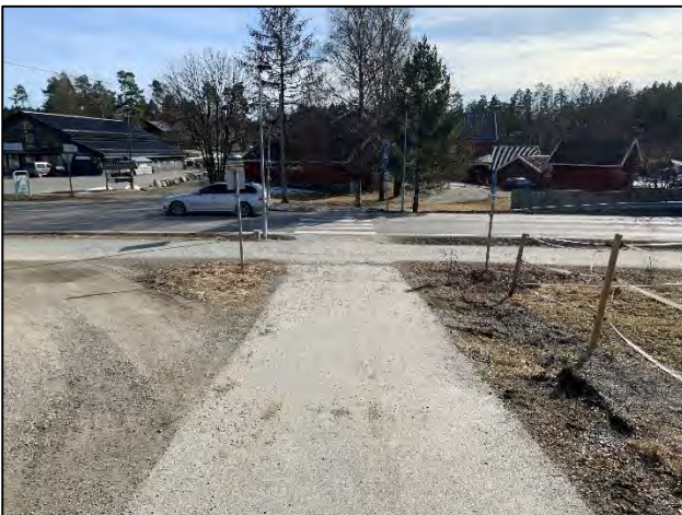
Overgang over Sonsveien
