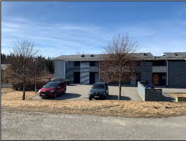
Tilstøtende boligbebyggelse i nordvest
